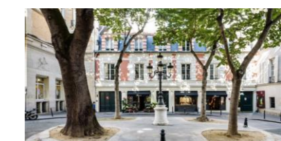
Rénovation – Place de Fürstenberg
